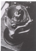
Rys. 1.47. Wymontowanie wirnika pompy ciecizy chłodzącej (za pomocą ściągacza)
