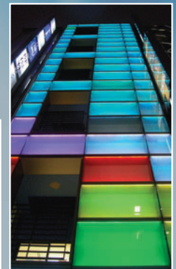
▲ 壁面イルミネーション Illumination wall
